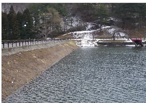
Fig. 1 被災前の藤沼ダム Fujinuma dam before collapse
